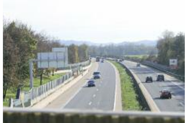
Die österreichischen Autobahnen sind durch Wildschutzzäune gesichert.
